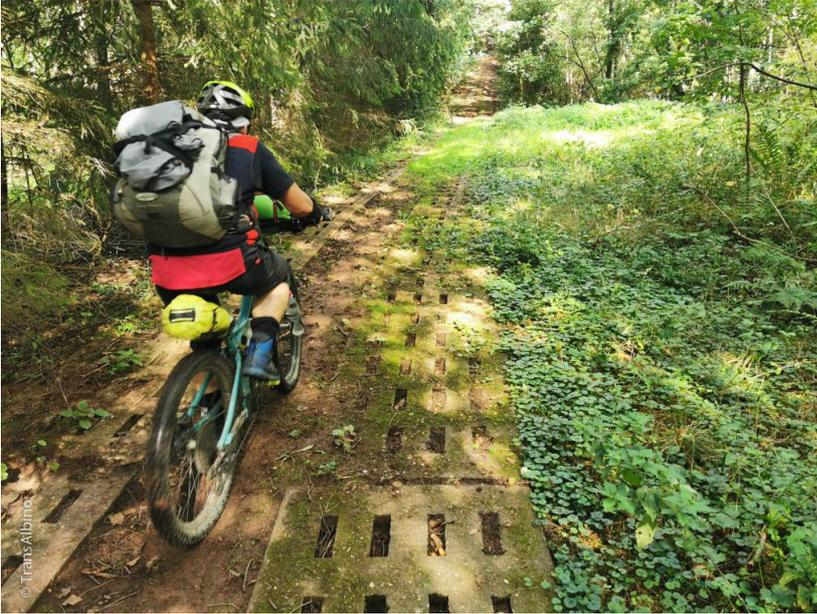
Auf der weiteren Strecke haben wir wieder einmal die Gelegenheit alle Typen der im Kolonnenweg verbauten Betonplatten im Vergleich zu testen. Bei den beiden überwiegend vorkommenden Platten handelt es sich um Fertigteile mit einer Grundfläche von 1 x 3 Metern. Darin eingelassen sind in Längsrichtung in 4 Reihen jeweils 7 rechteckige Schlitzte. Deutlich seltener sind die gleich großen Platten mit denselben Schlitzten in
